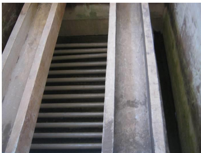
Εικόνα 2.7: Δεξαμενή διύλισης χωρίς την κλίνη (άμμο) διύλισης και τη σίτα συγκράτησης. Διακρίνονται οι πλευρικοί διάτρητοι σωλήνες. (Από φωτογραφίες εγκατάστασης)
