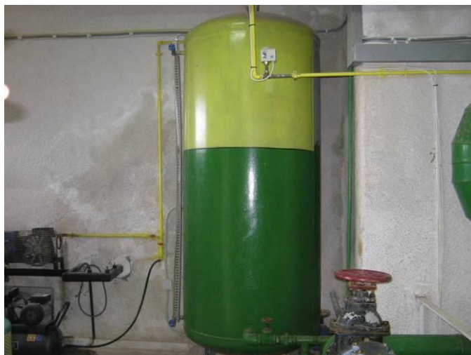
Εικόνα 2.10: Φυλάκιο αέρα- νερού (με κίτρινο χρώμα αέρας υπό πίεση και πράσινο νερό υπό πίεση)
