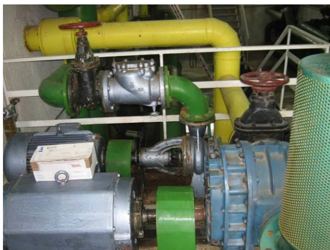
Εικόνα 2.8: Αντλίες - κομπρεσέρ
