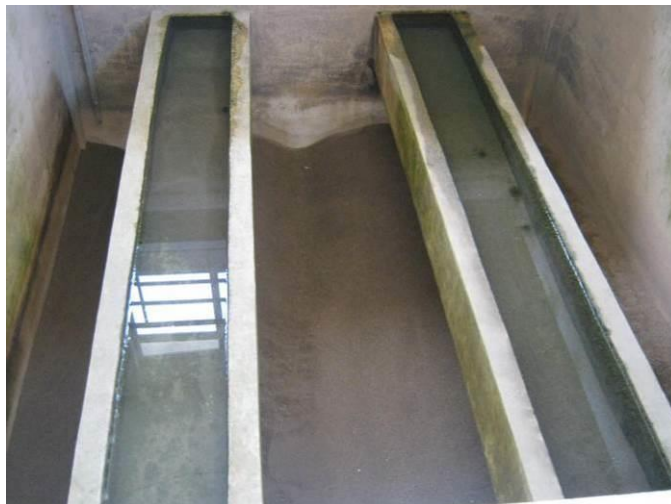
Εικόνα 2.6: Δεξαμενή διύλισης. Διακρίνεται η κλίνη άμμου (Από φωτογραφίες εγκατάστασης)
