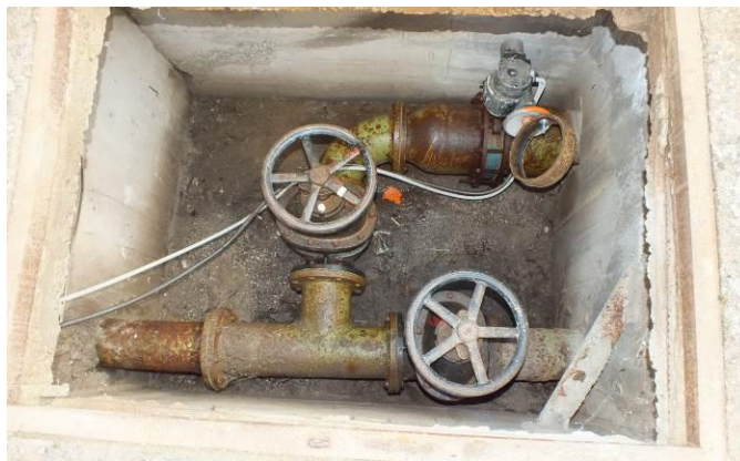
Εικόνα 2.12: Έξοδος διυλιστηρίου – Αγωγός προς Φρεάτιο Άμφισσας
